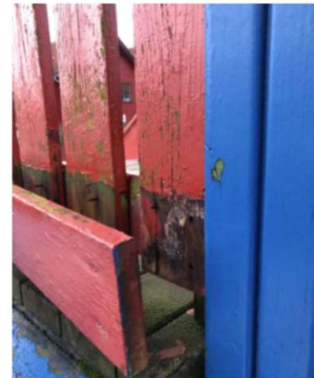
Råteskader
